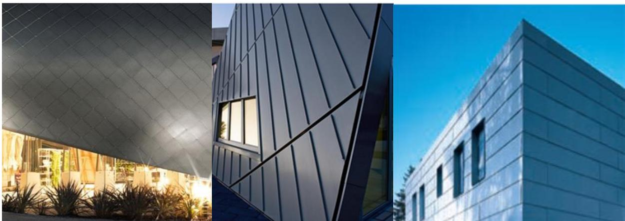
Abbildung 15: Beispiele gegliederter Blechflächen durch Rautenbildung oder Quer- bzw. Längsunterbrechung der Bahnen
