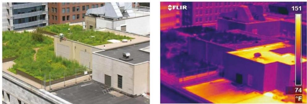
Abbildung 27 - Differenz der Oberflächentemperatur mit und ohne Begrünung auf der Dachfläche des National Center of Excellence, Arizona State University (Bilder: U.S. Environmental Protection Agency, 2008 Reducing Urban Heat Islands: Compendium of Strategies)
