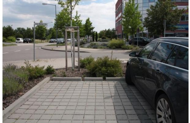
Abbildung 148 - Bei diesem Parkplatz kann das Oberflächenwasser direkt und im angrenzenden Pflanzbeet oberflächlich versickern; gutes Beispiel auf Privatgelände im Gewerbegebiet Am Messegelände in Landau (Bild: faktorgruen).
