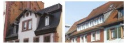
Kombination Zwerchhaus und Gaube mit gleicher Dachform. Horizontale Gaube in zweier Reihe (mit Dachziegel) nicht zulässig.
