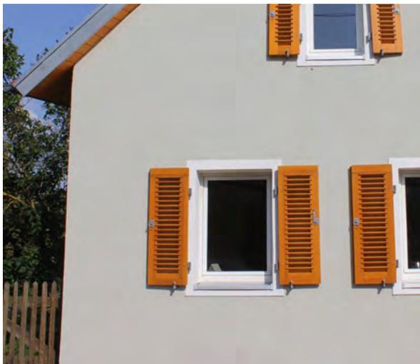
Fassadendämmung unter optischer Wiederherstellung der historischen Fenstergewände und Wiedereinbau der Klappläden
