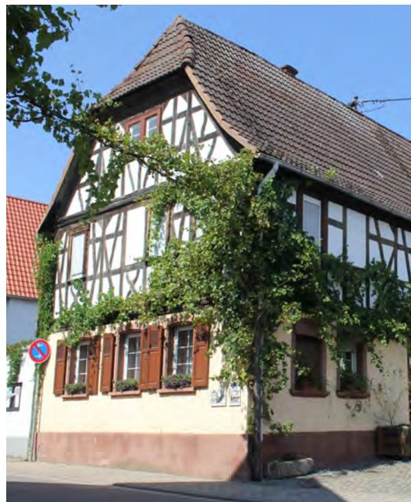
Lage und Größe der Fenster sind abhängig von der Konstruktion: Durch Fachwerkstände andere Gliederungsvorgaben als im Massivbau.
