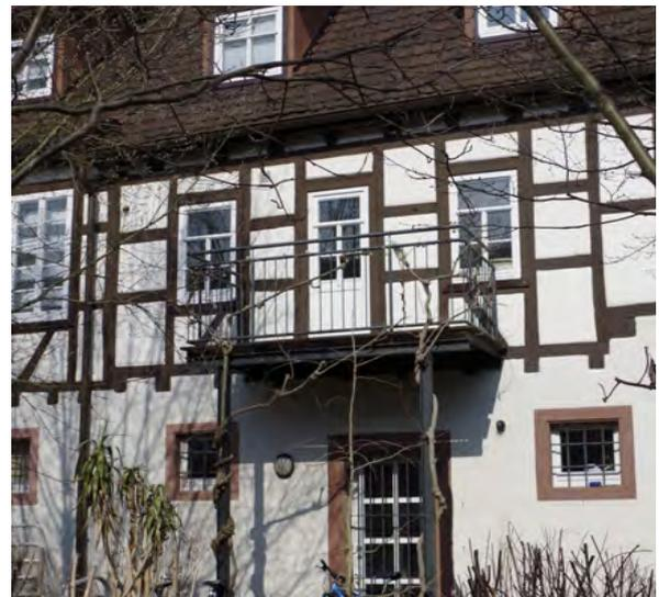
Nachträglich angebauter Balkon an einer Fachwerkfassade: Die Fassade wird nicht verdeckt.
