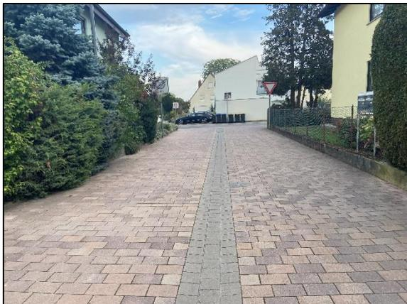
Abbildung 26: Entwässerung Am Neuberg – negatives Dachprofil
