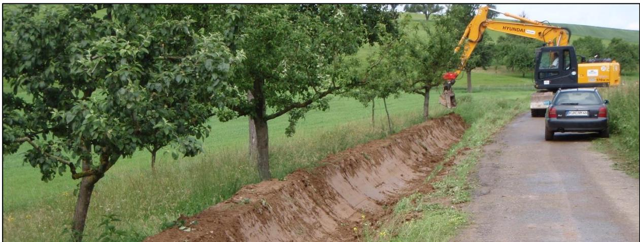
Abbildung 34: Unterhaltungsarbeiten an einem Grabensystem
