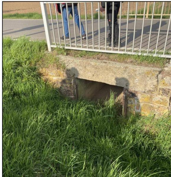
Abbildung 39: Durchlass des Schleidgrabens unter der K1, Blick Richtung Nordosten
