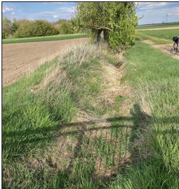
Abbildung 40: Schleidgraben am Durchlass unter der K1, Blick Richtung Nordosten
