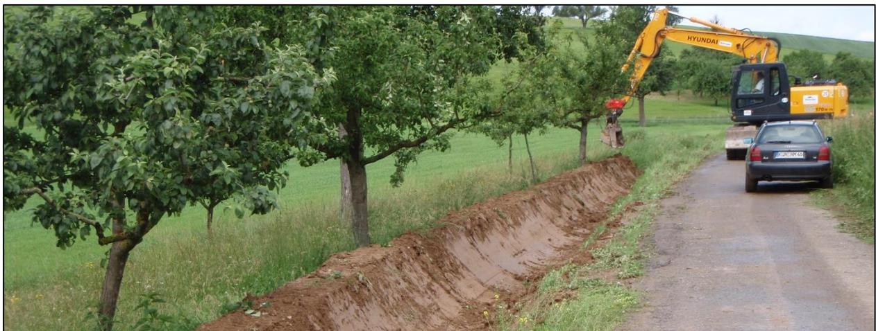
Abbildung 38: Unterhaltungsarbeiten an einem Grabensystem
