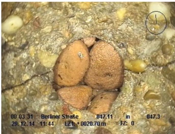
Abb 2: Beispiel Schadensbild BAO, Boden sichtbar
