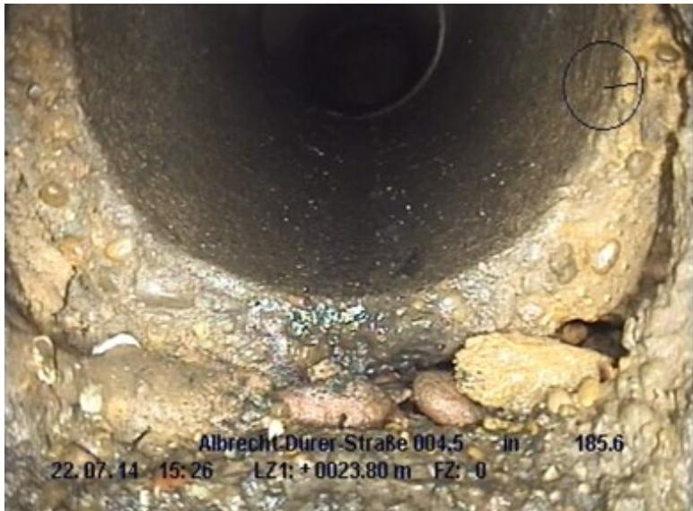
Abb 4 BAP Hohlraum sichtbar im Bereich eines Anschlusses
